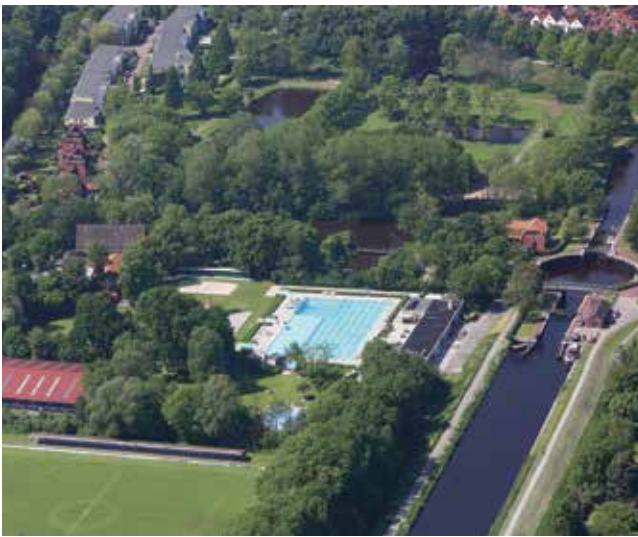
van-Ameren-Bad mit Kesselschleuse, Foto: Karlheinz Krämer
